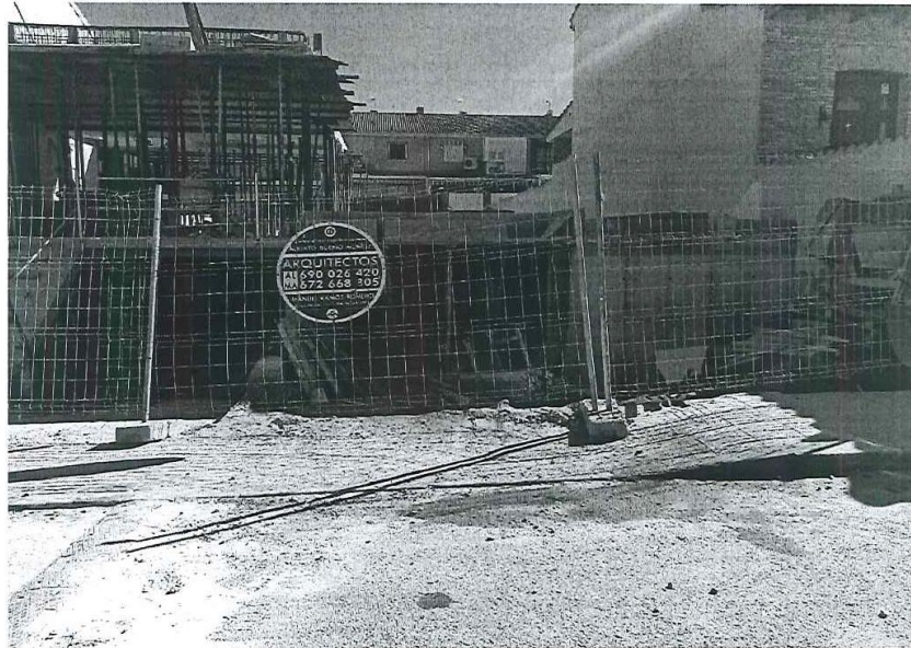
FOTO Nº 1: Vista general de las inmediaciones de la obra.
