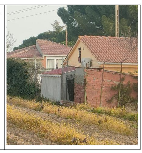
Se observa una canal de PVC que recoge las aguas del faldón de cubierta. No se observa ninguna ventana o hueco en dicho volumen.
