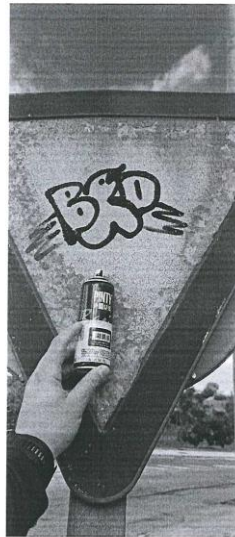
Fotografía nº3: Fotografía de las pintadas realizadas sobre la señal R-1
