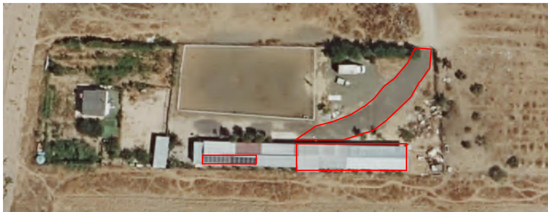
Ampliación de fotografía de la zona de la edificación.
