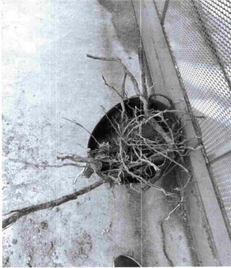
Foto 4. Raíces retiradas para la reparación del atranco producido por las raíces en tubo de salida de aguas fecales.
