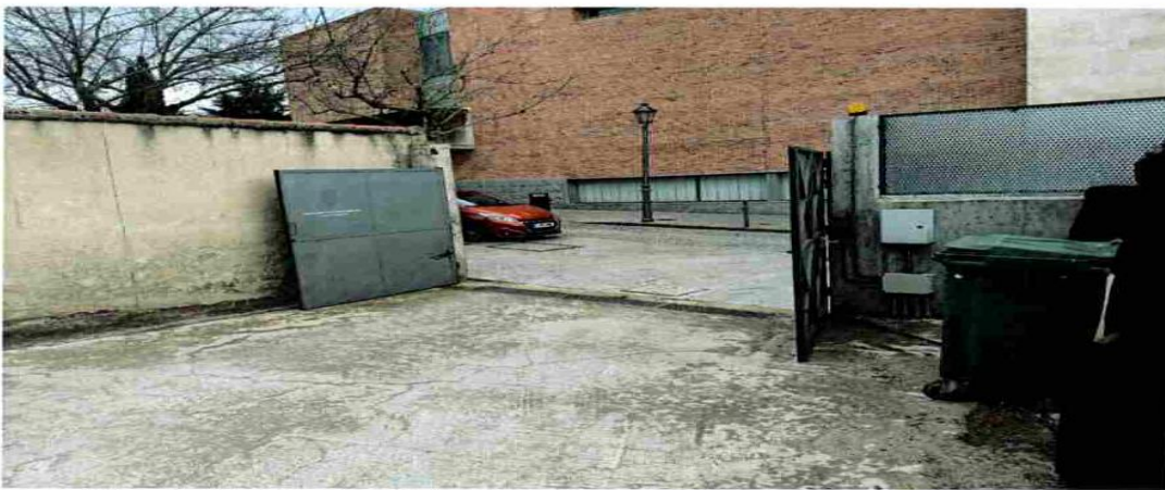
Puerta del garaje del Parking de PL de la Calle donde, con la puerta derecha sin brazo.
