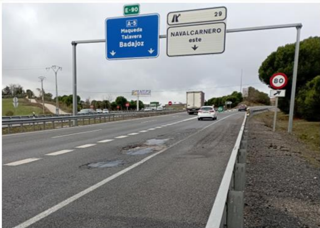
Estado de alguna de las cárcavas con socavado
