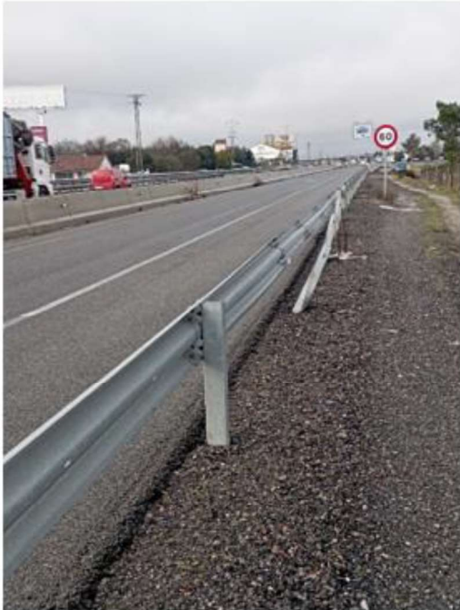
Estado de alguna de las barreras de contención metálicas en la vía de servicio y rotonda tras accidentes
