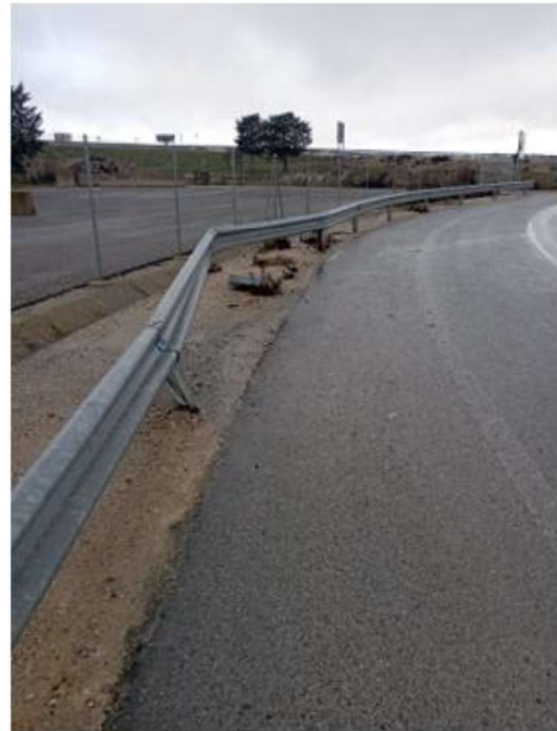
Estado de alguna de las barreras de contención metálicas en la vía de servicio y rotonda tras accidentes
