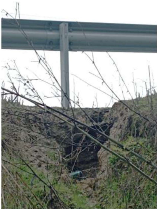
Estado de alguna de las cárcavas con socavado
